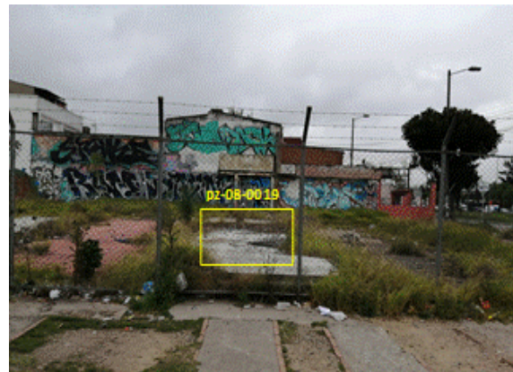
Fotografía No. 2 Vista frontal de la ubicación del pozo
